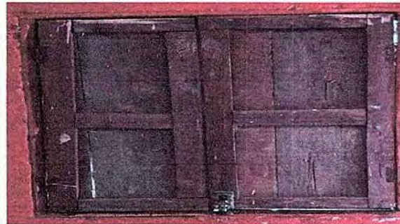
Foto 4: Se evidencia el mal estado de las ventanas del establecimiento.
