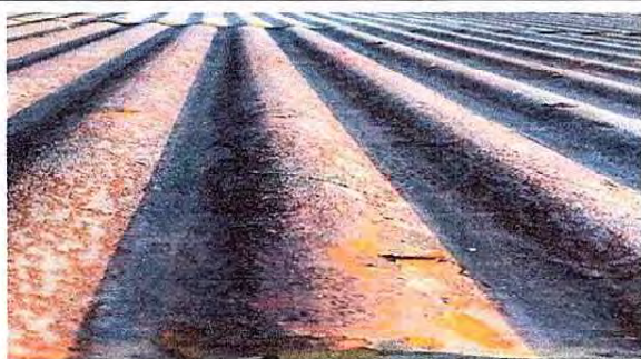
Foto1: Se evidencia el estado actual del techo de lámina del establecimiento
