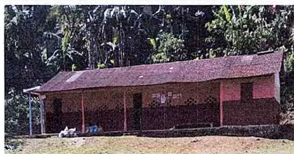
Foto 6: Se evidencia el mal estado de el techo de lámina y la falta de canales de captación de agua pluvial
