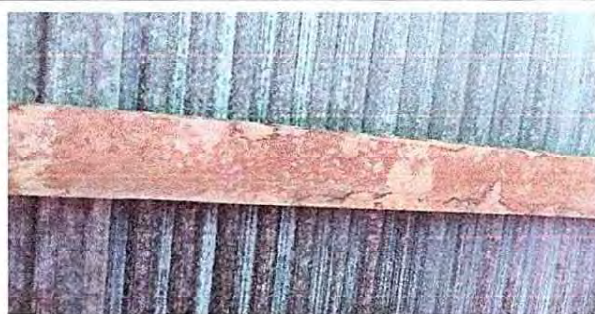
Foto 2: Se evidencia el mal estado de la viga o costanera de la estructura de lámina de la escuela.
