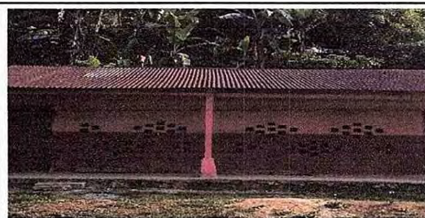
Foto 12: Se evidencia el mal estado de el techo de lámina y la falta de canales de captación de agua pluvial
